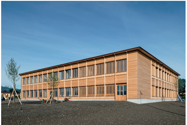
«Rhyboot»-Neubau «Bleiche», Altstätten SG
